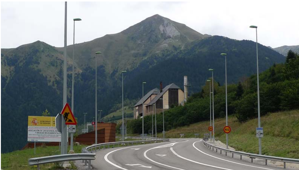
Figura 4 Vista zona ampliació edificis
