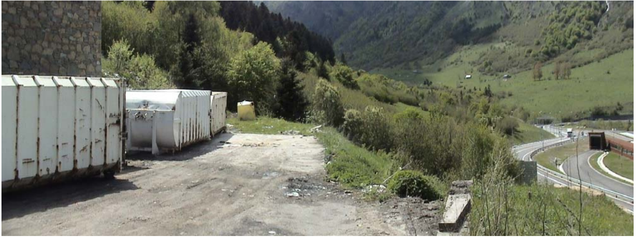
Figura 3 Vista zona ampliació edificis
