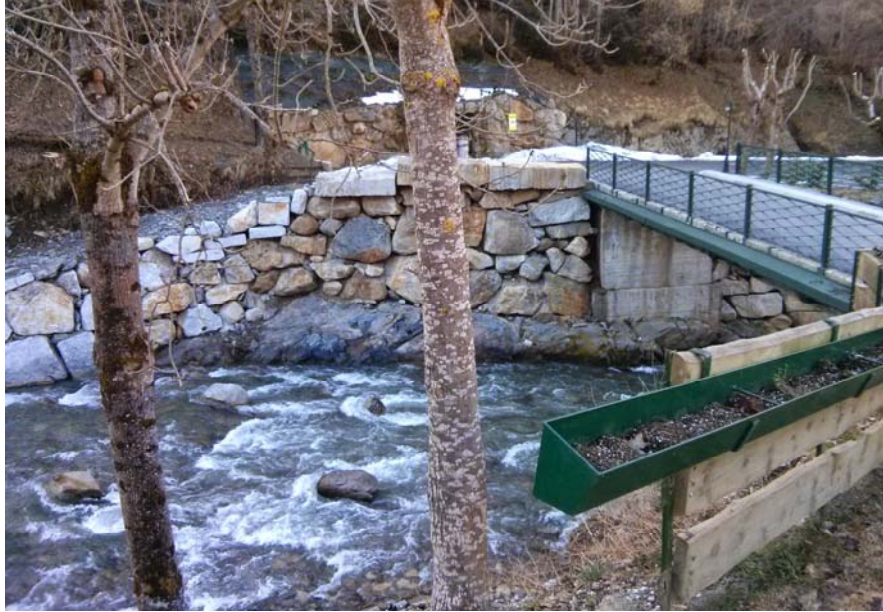
Vista de puente de acceso con luz de 14m y altura libre 4,90 m.
