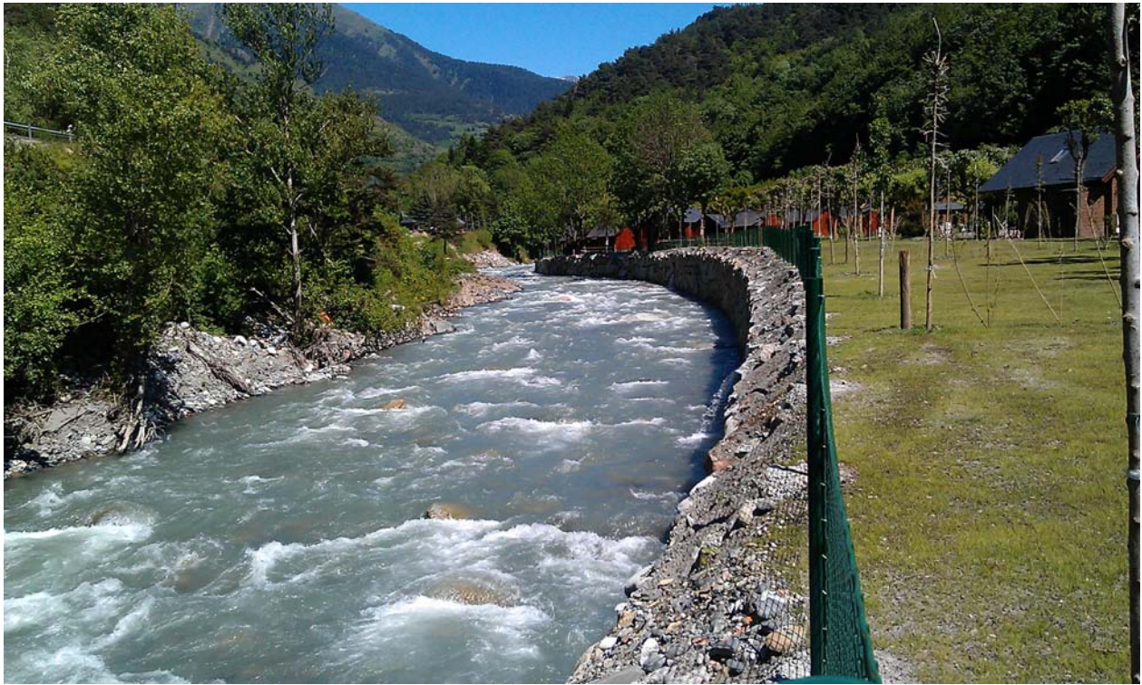
Fotografía núm. 5: Vista de tramo protegido en su parte final (p.k. 0+445)
