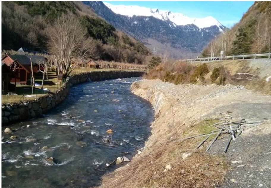
Vista de protección de margen izquierdo con escollera desde zona de bungalows (p.k.0+2805)
