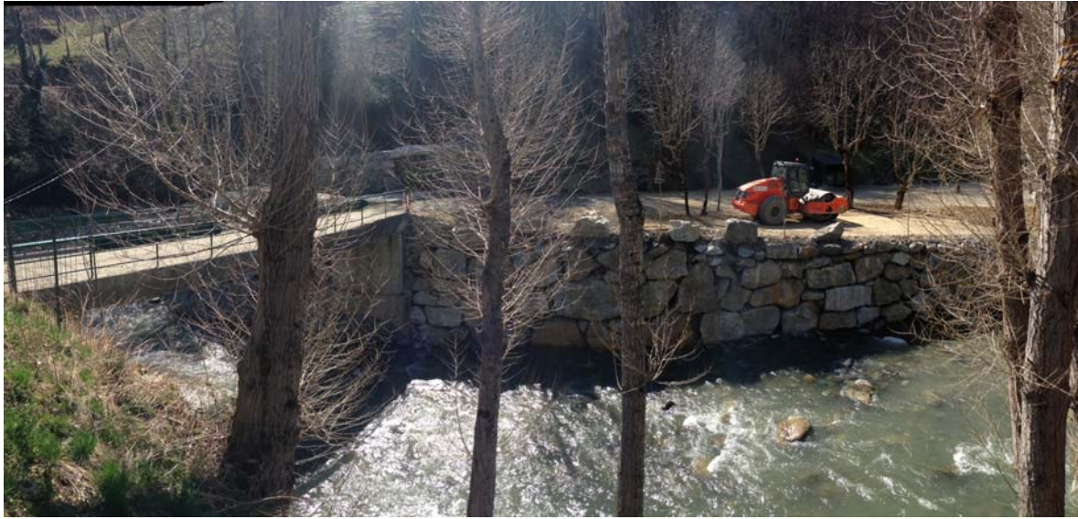
Fotografía núm. 3: Vista de protección de escollera a la salida del puente (Hmáx = 4,90 m)
