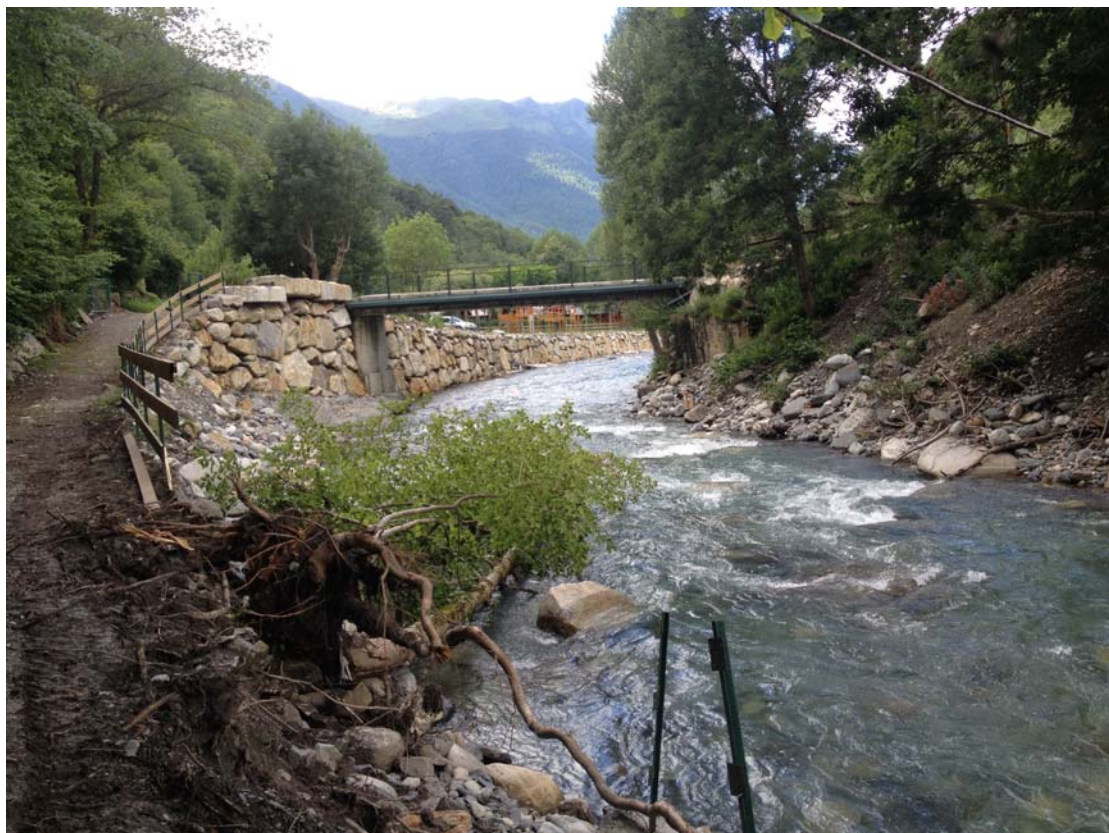
Fotografía núm. 2: Vista del paso del río por el puente existente.
