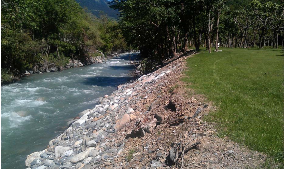
Fotografía núm. 7: Vista de tramo en estado natural, no protegido en zona final del camping (p.k. 0+640)
