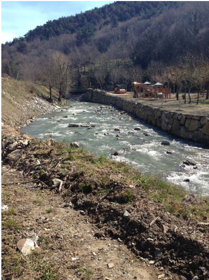
Fotografía núm. 4: Vista de cauce principal en zona de bungalows
