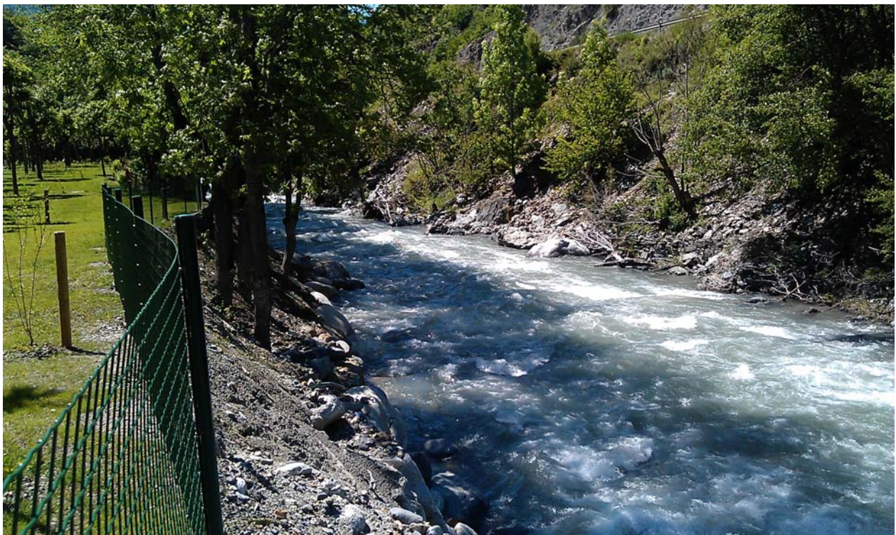
Fotografía núm. 6: Vista de tramo en estado natural, no protegido en su parte inicial (p.k. 0+445)
