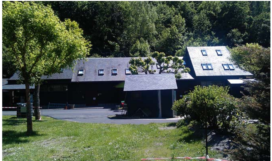
Foto 46: Vista general edifici de serveis.
