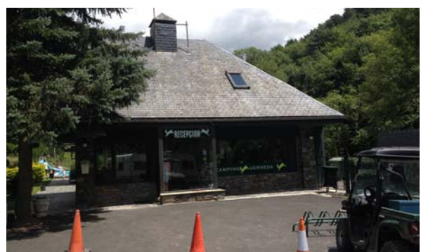
Foto 14: Edifici principal situat a l'entrada del càmping.
