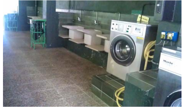
Foto 50: Edifici de serveis – bugaderia i safarejos.
