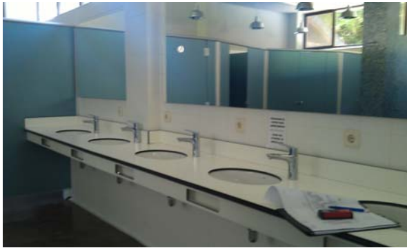
Foto 49: Edifici de serveis - lavabos.
