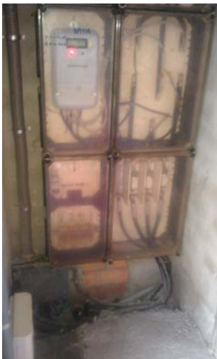
Foto 45: Escomesa elèctrica marge esquerre.
