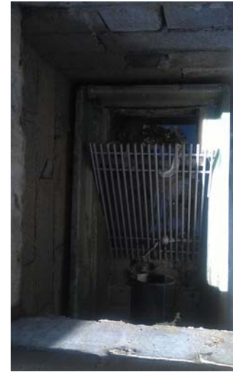
Foto 64: EDAR – reixa de desbast.
