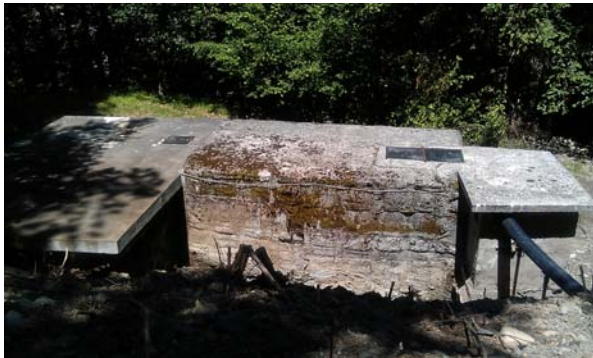
Fotos 71 i 72: Dipòsits existents d'aigua potable (30+15 m 3 ) i caseta de cloració.
