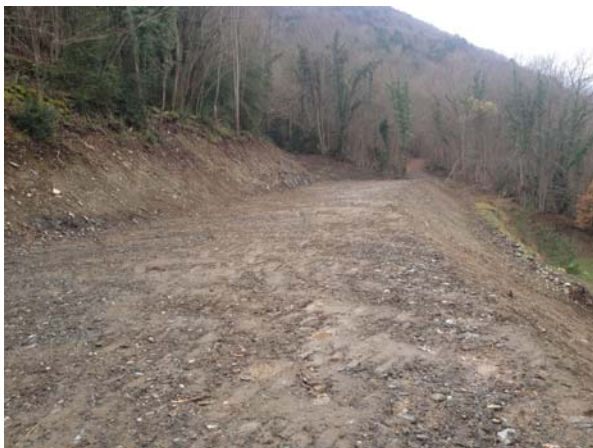
Foto 73: Moviment de terres en la zona d'ampliació al sud del camí Reiau.
