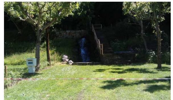
Foto 42: Salt d'aigua canalitzat per sota el càmping.
