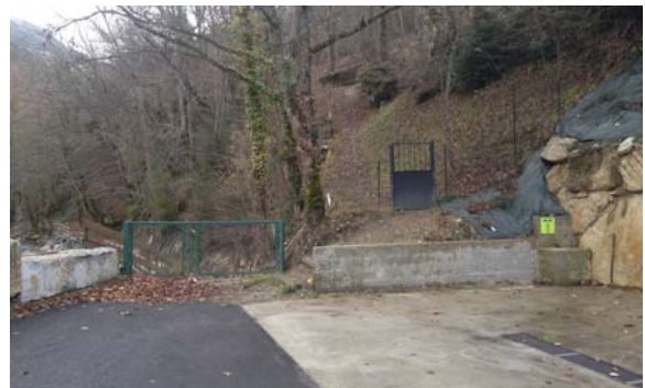
Foto 26: Sortida d'emergència i accés a la zona d'ampliació situada aigües amunt del pont sobre la Garona.
