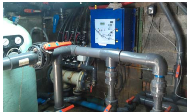
Foto 18: Equips de depuració de les piscines.
