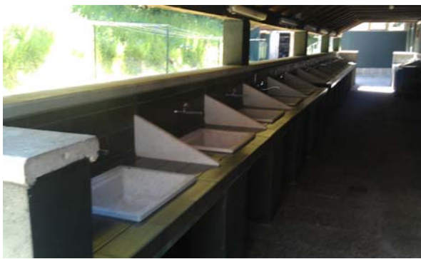
Foto 51: Edifici de serveis – piques zona de rentat.
