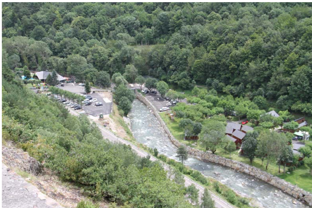
Foto 82: Vista general del marge dret del càmping i zona de bungalows existents en el marge esquerre.
