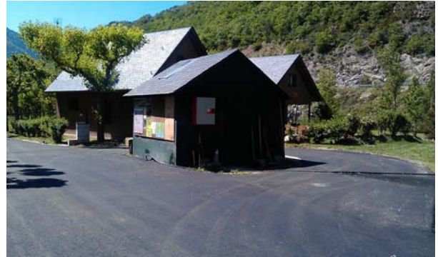
Foto 44: Caseta escomesa elèctrica - magatzem.
