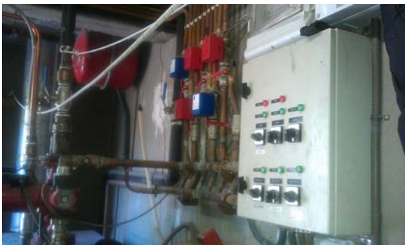
Fotos 47 i 48: Equips caldera per ACS i calefacció en edifici de serveis.
