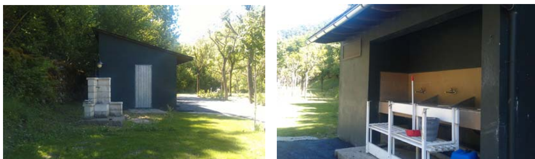
Edifici de serveis existent a ampliar en el límit de ponent del càmping
