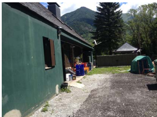
Façana on adossar l'ampliació de la cuina
