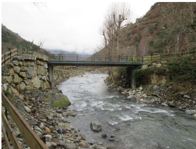
Pont sobre el riu Garona - vial intern del càmping
