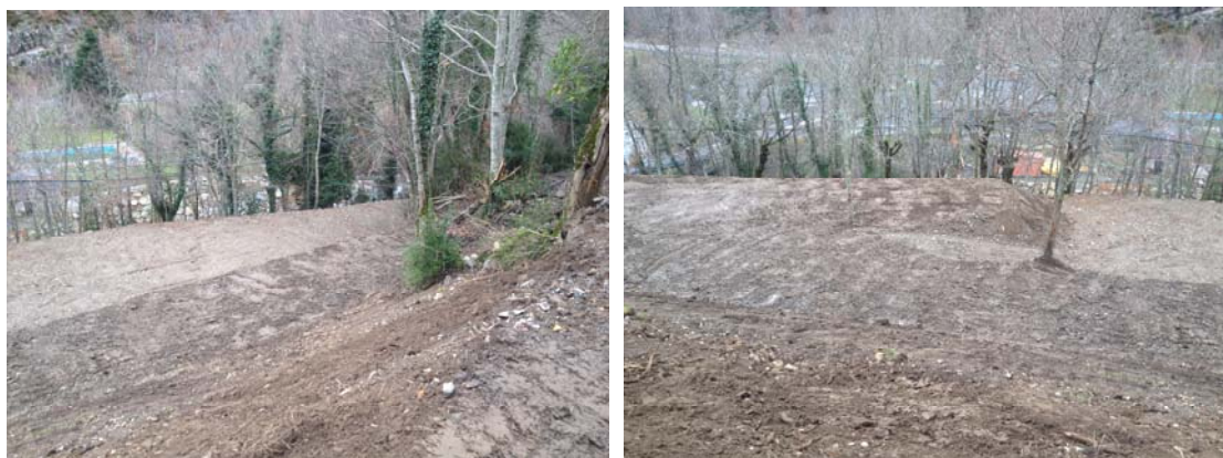
Zona al sud del camí Reiau on s'ha realitzat el moviment de terres en previsió d'instal·lació de nous bungalows.
