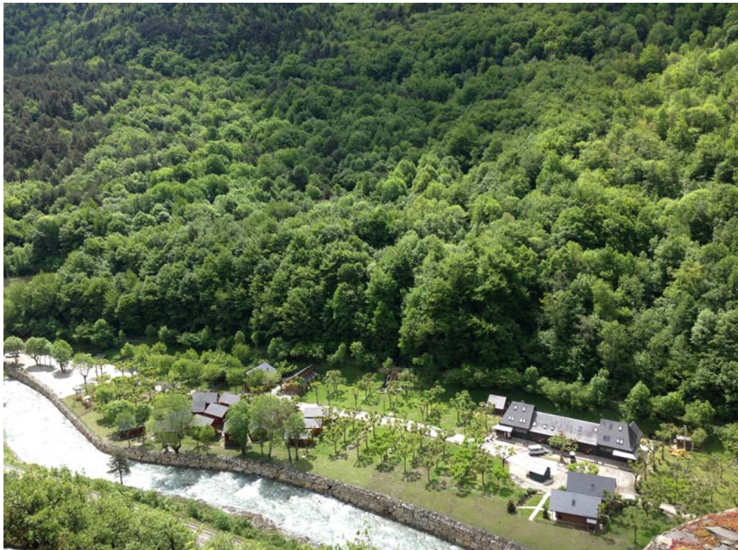
Foto: Foto on es veu l'escullera construïda
