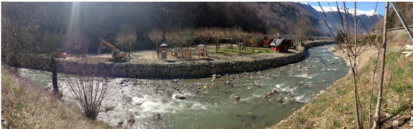
Foto: Vista de l'escullera construïda
