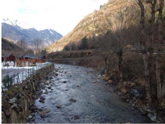
Vista de l'escullera i tanca existent en el marge esquerre del riu.
