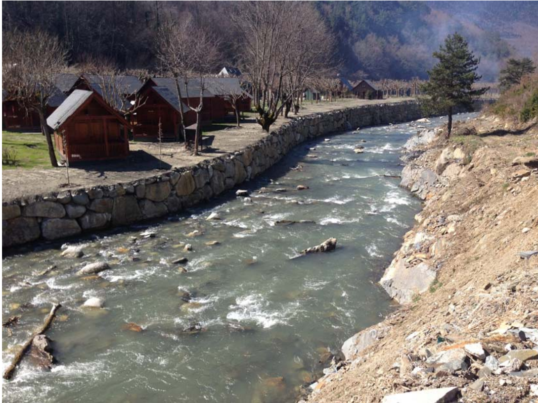
Foto: Vista de l'escullera construïda a la zona dels bungalows.
