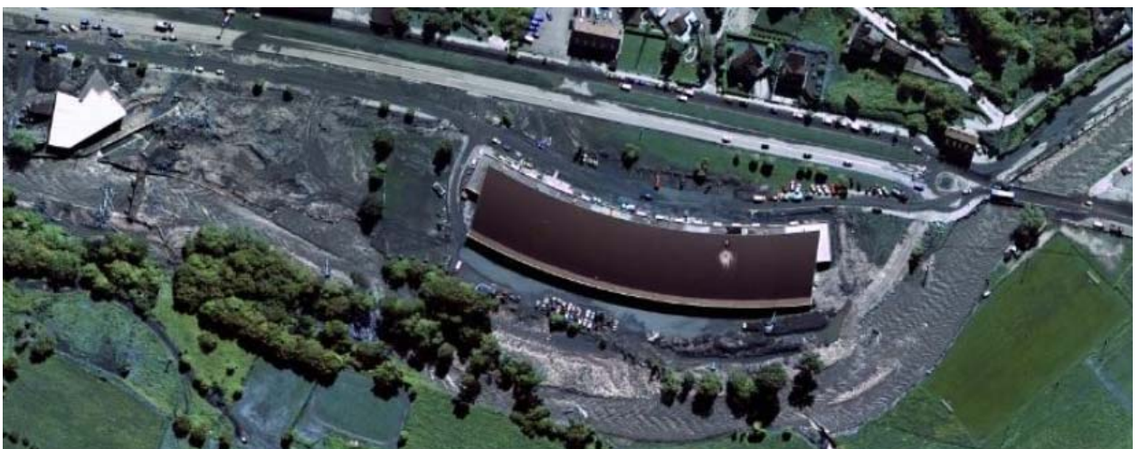
Inundacions de l'any 2013 en la zona industrial (Vielha Industrial)
