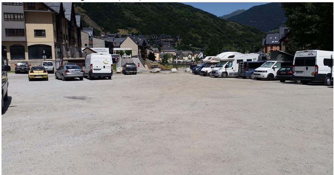
Fotografia 05. Espai on s'embassa l'aigua en la zona a pavimentar.
