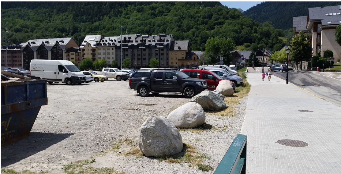
Fotografia 04. Espai a pavimentar. Carrer dera Querimònia.
