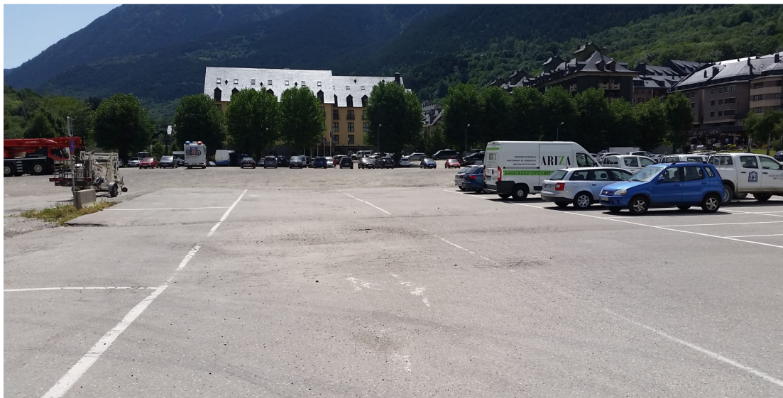
Fotografia 06. Zona a reparar i pavimentar.
