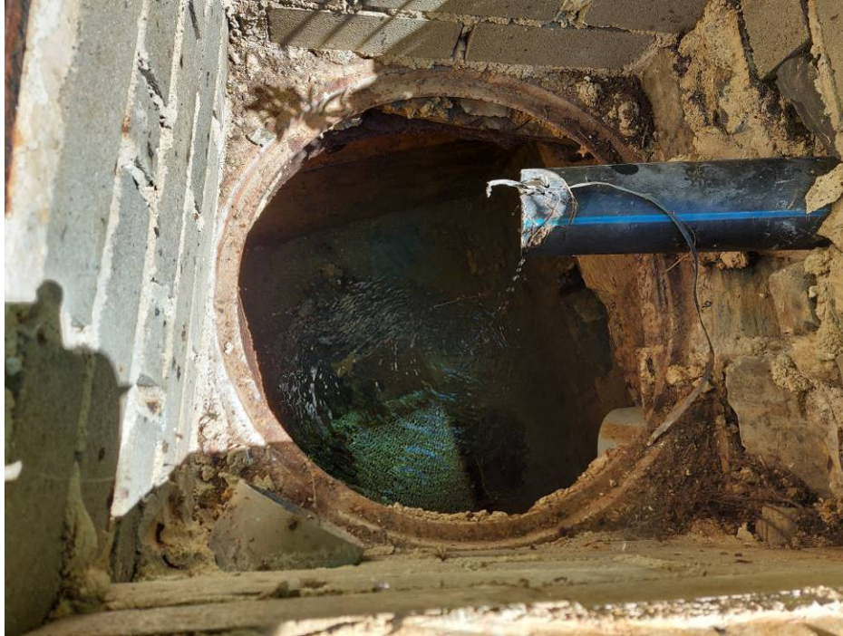
Vista de arqueta de captación de la Fuente de Dur. Se aprecia la tubería de entrada procedente del barranco des Pales
