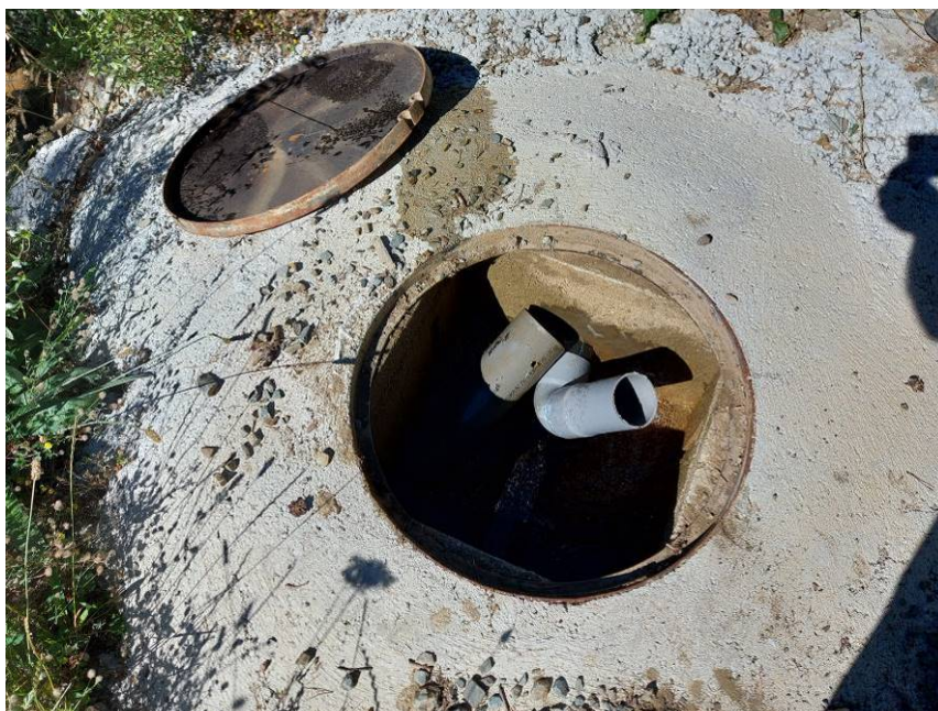
Vista de arqueta A-1 de desconexión de tubería en alta del barranco des Pales
