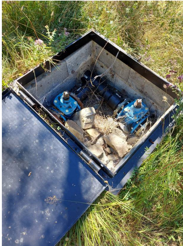
Vista de arqueta A-2 de by-pass de caudales de tubería de Vila a tubería de Arròs.
