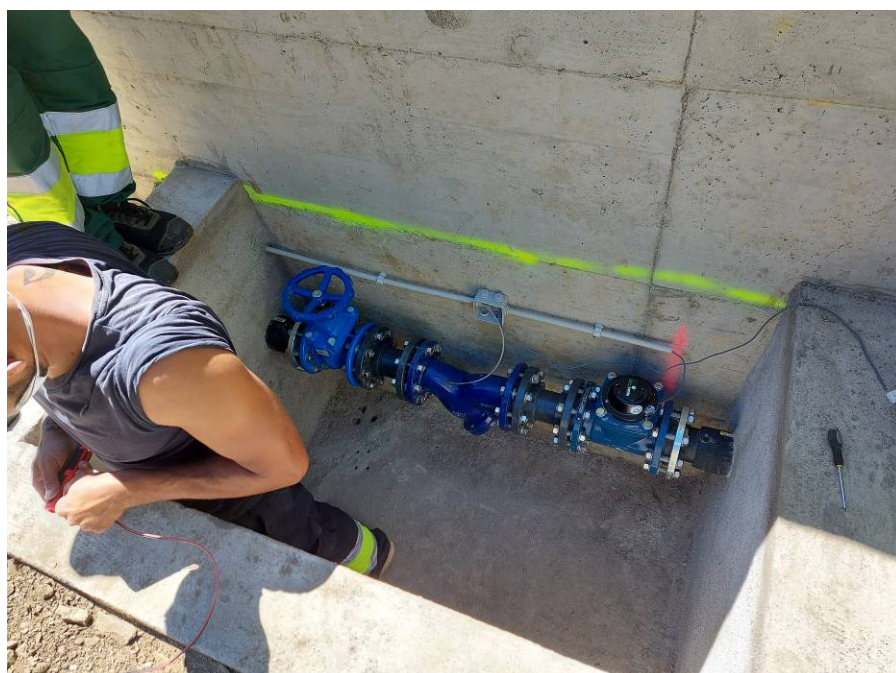
Vista de arqueta de entrada depósito de Arròs, filtro, válvula de cierre y contador Woltmann.
