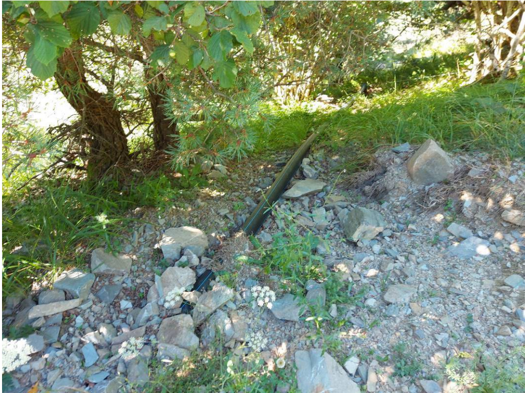
Vista de tubería en alta PEAD DN 90 mm del barranco des Pales, en el giro hacia el sur.
