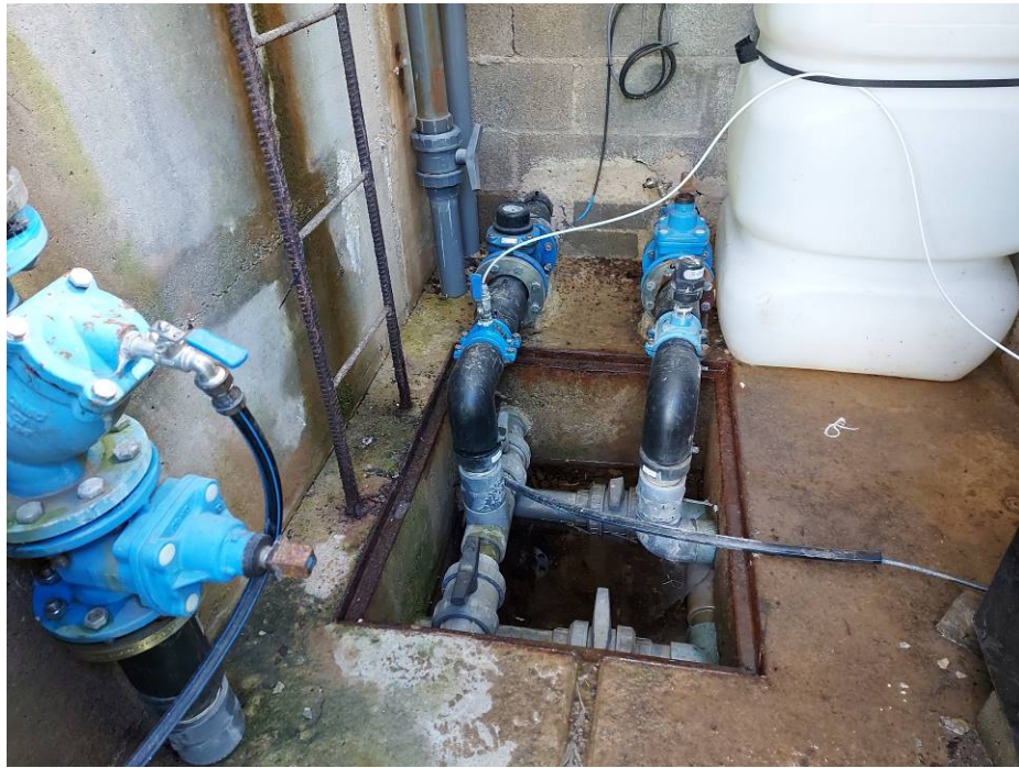
Vista de tubería de entrada (derecha) y de salida con contador Woltamn (izquierda)
