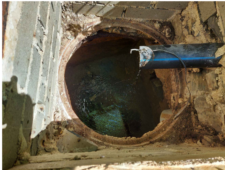
CAPTACIÓN FUENTE DEL DUR
