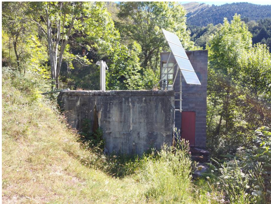
Vista de depósito de Vila y caseta de válvulas
