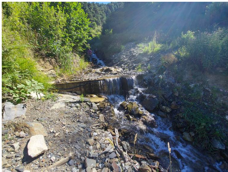
Vista general de murete transversal de captación del barranco des Pales
