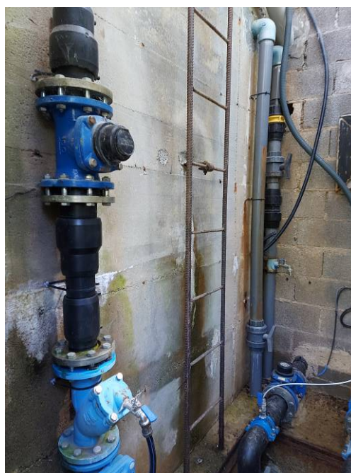
Vista de tubería PEAD DN 90 mm y contador Woltmann de entrada
