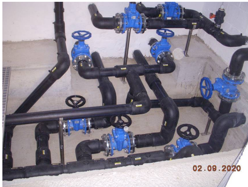
Vista de interior de caseta de válvulas, tuberías de entrada desde arqueta exterior, desagües de fondo y tubería de salida de PEAD DN 75 mm hacia el núcleo de Arròs.
