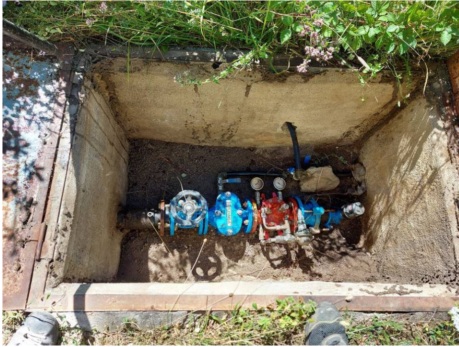
Vista de arqueta A-3 con válvula reductora de presión en tubería de Vila
