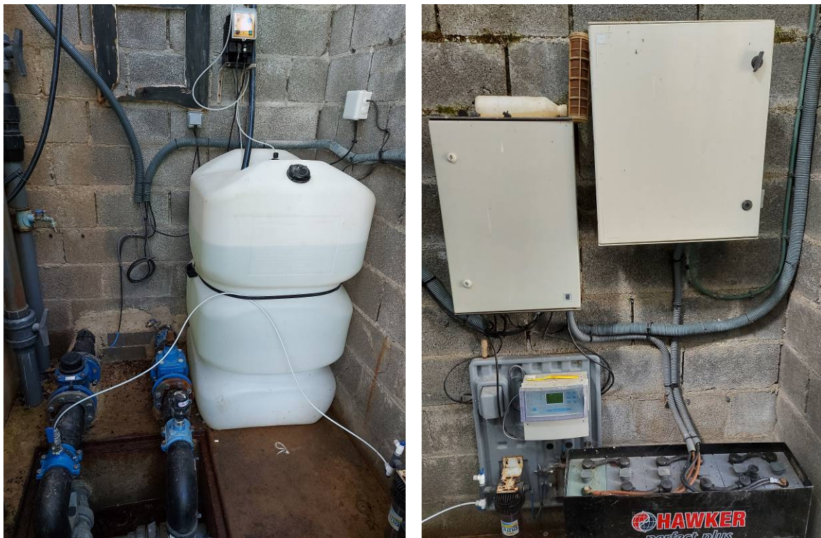
Vista de equipo de cloración en continuo
