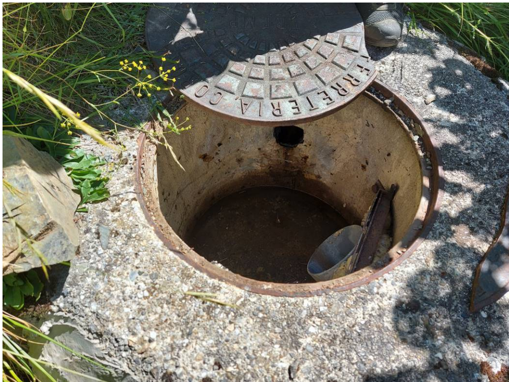
Vista de pozo P-1 de rotura de carga de tubería en alta del barranco des Pales
