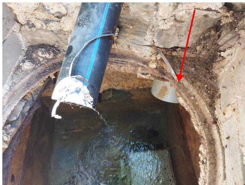
Vista de aliviadero lateral en arqueta de captación Fuente de Dur
