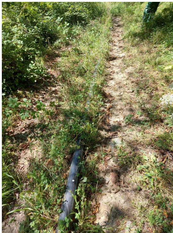
Vista de tubería en alta del núcleo de Arròs, a la altura del depósito de Vila
