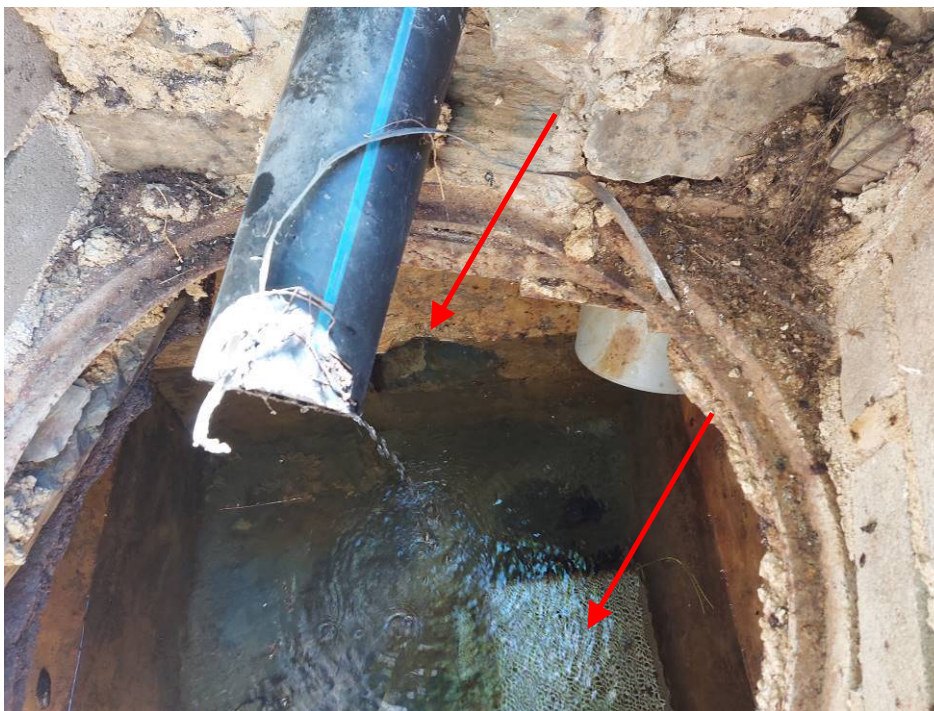
Vista de entrada de agua del manantial y filtro de acero inoxidable de tubería de salida hacia el depósito de Vila
