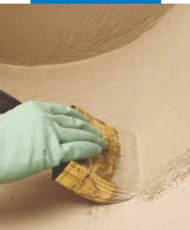
Impermeabilización de muro de cimentación a brocha
