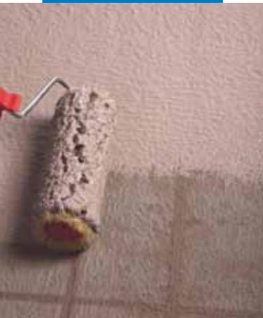
Impermeabilización de muro de cimentación a rodillo
