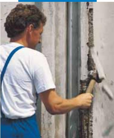
Demolición del hormigón degradado
