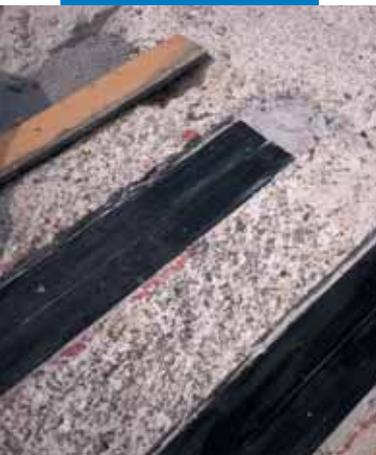
Lámina de Carboplate aplicada, en el lugar adecuado, sobre el tablero
