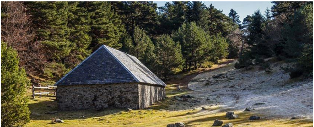
Vista de la Borda dera Vila de Gausac – altitud 1.636m – imagen margen inferior – construcción tradicional -
