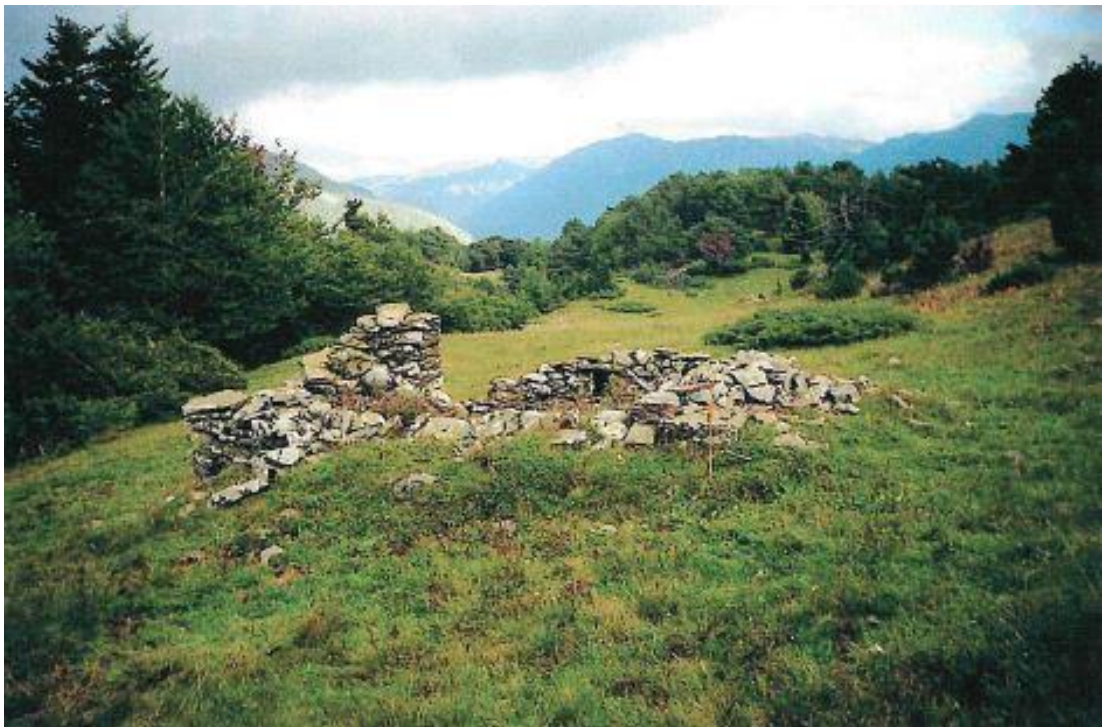
Restos de la antigua cabana que existía en la parcela en el año 2000-2001 sobre las cuales se realizó el Informe de los Servicios Técnicos municipales de Vielha.
