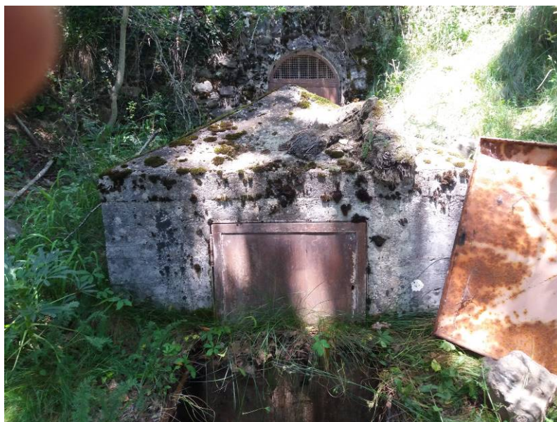
Vista de arqueta de salida.
