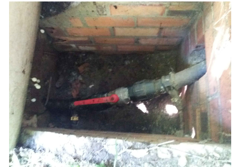
ARQUETA DE ENTRADA AL DEPOSITO
