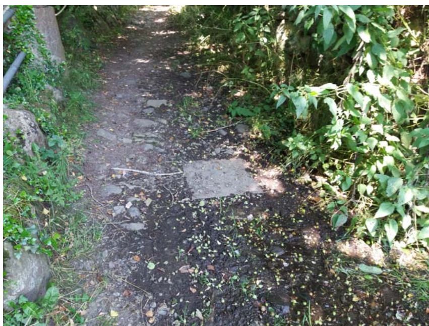
Vista de arqueta de llegada a zona de inicio de red de distribución
