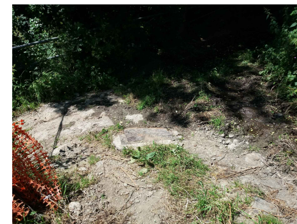
ARQUETA 2 : VALVULA EN CONDUCCIÓN DE NAVASI
