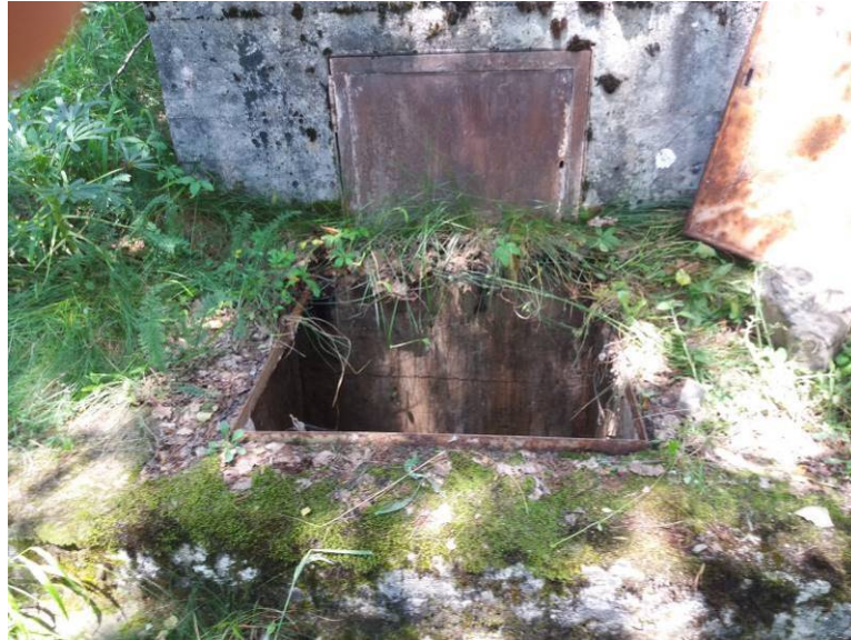
Vista de arqueta de ubicación de válvula de seccionamiento.
