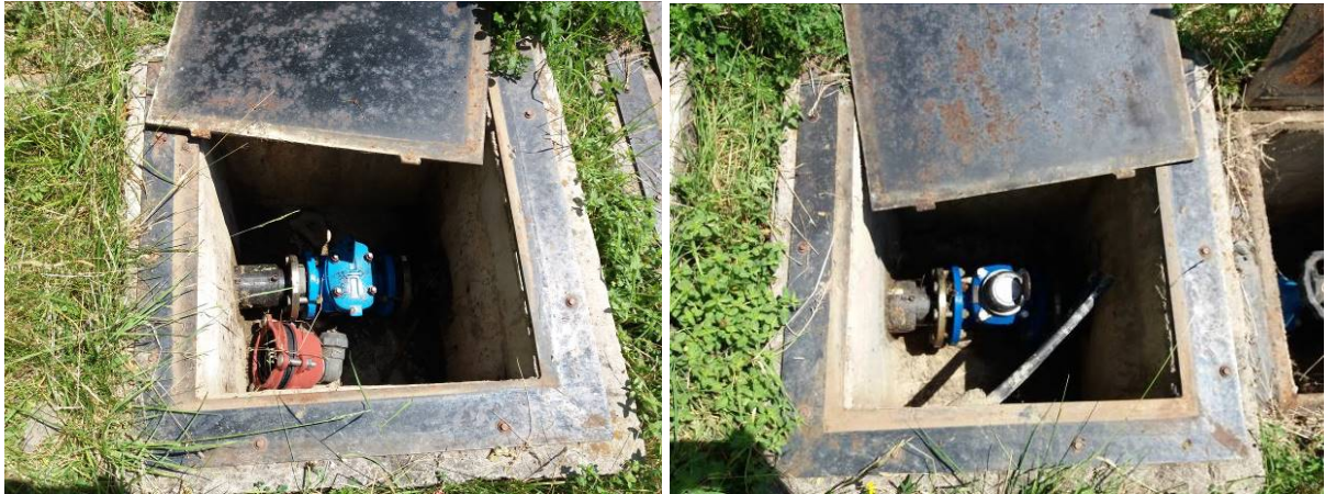
Vista de filtro (izquierda) y contador tipo Woltmann DN 100 mm (derecha)
