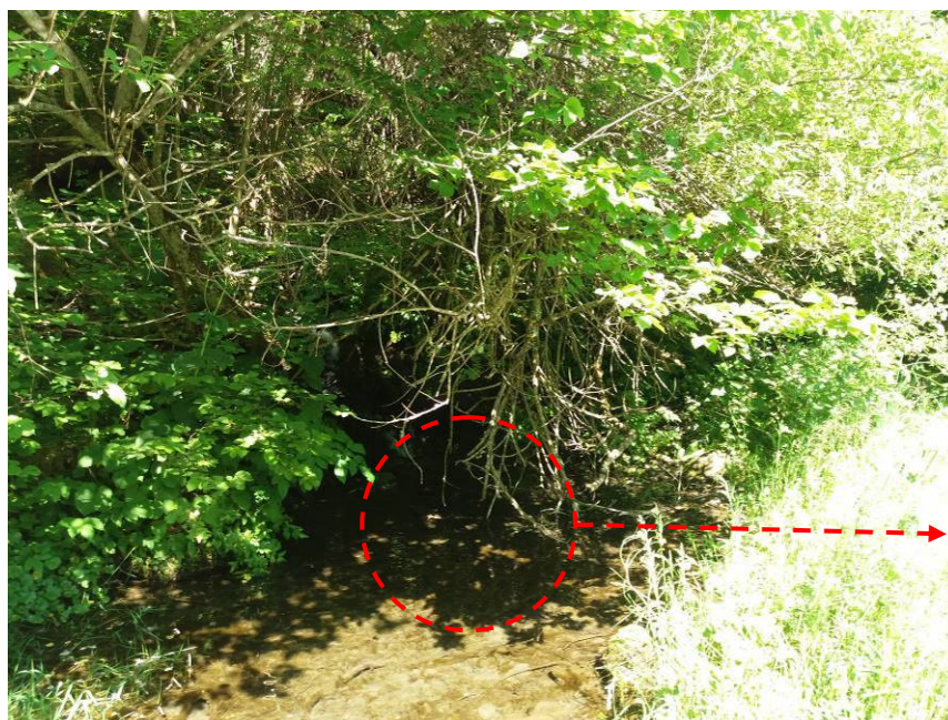
Vista de punto de zona captación de surgencia de agua en lado izquierdo de camino de Badiero, a una distancia de 2 m del mismo, mediante zanja de 3 m de longitud y 2 m de anchura con 3 tubos drenantes ranurados de PEAD DN 200 mm.
