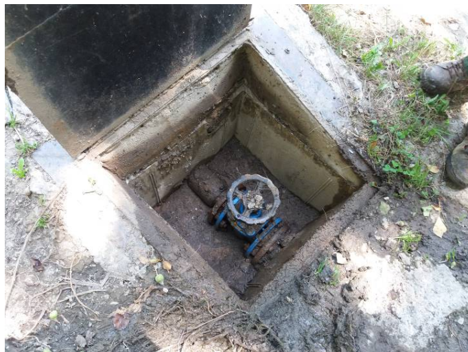
Vista de arqueta en conducción de Naviasi, antes de intercepción con conducción de inicio de red de distribución.
