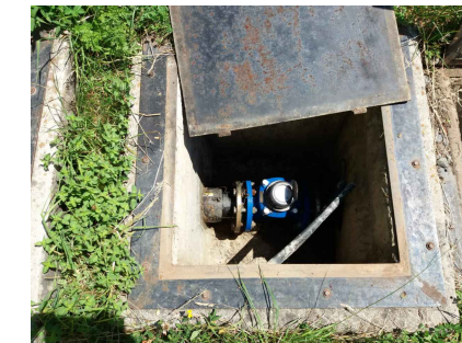
CONTADOR TIPO WOLTMANN (4)
