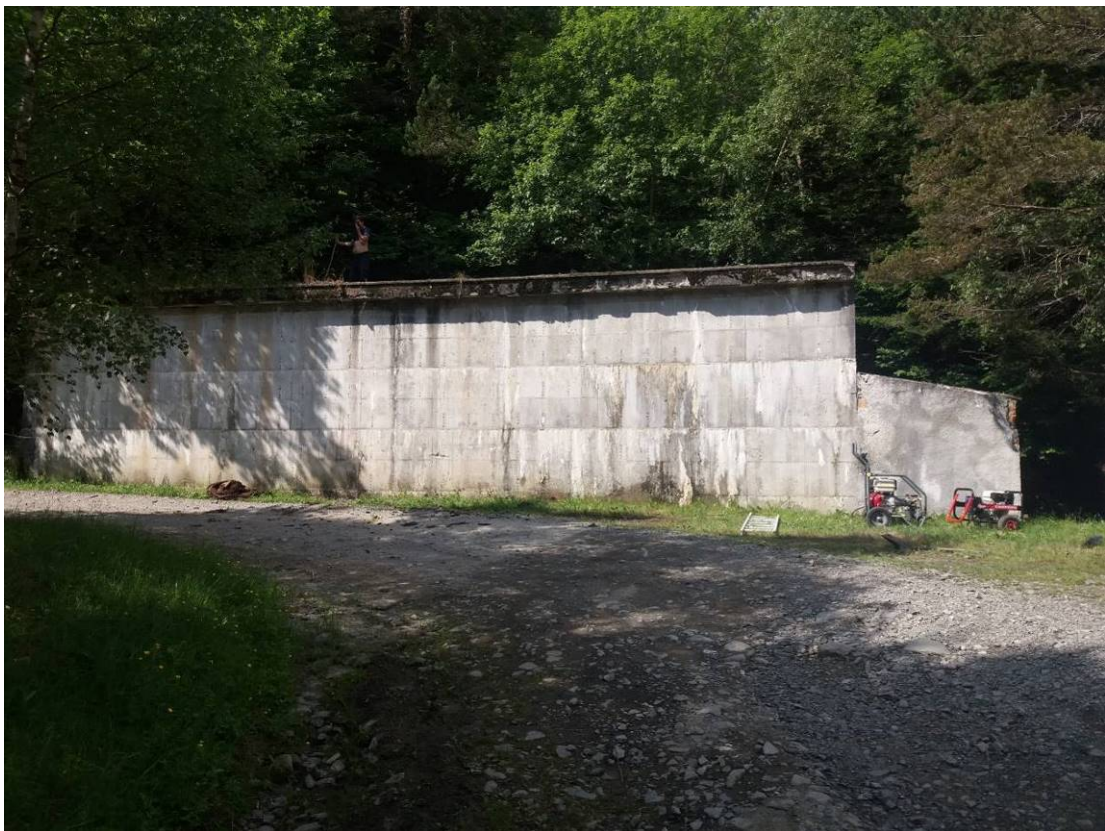
Vista exterior de depósito existente de 14 m de longitud, 6.30 m de anchura y 4.20 m de altura interior, ejecutado con hormigón armado y forjado en cubierta de viguetas pretensadas. Se aprecia también la caseta de válvulas exterior al depósito.
