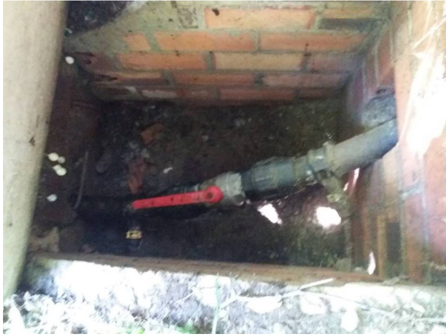
Vista de arqueta de entrada a depósito existente y válvula de bola en su interior.
