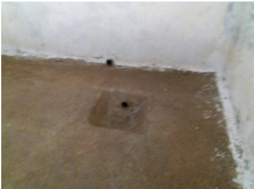
Vista interior de salidas de desagüe y alimentación de conducción existente.
