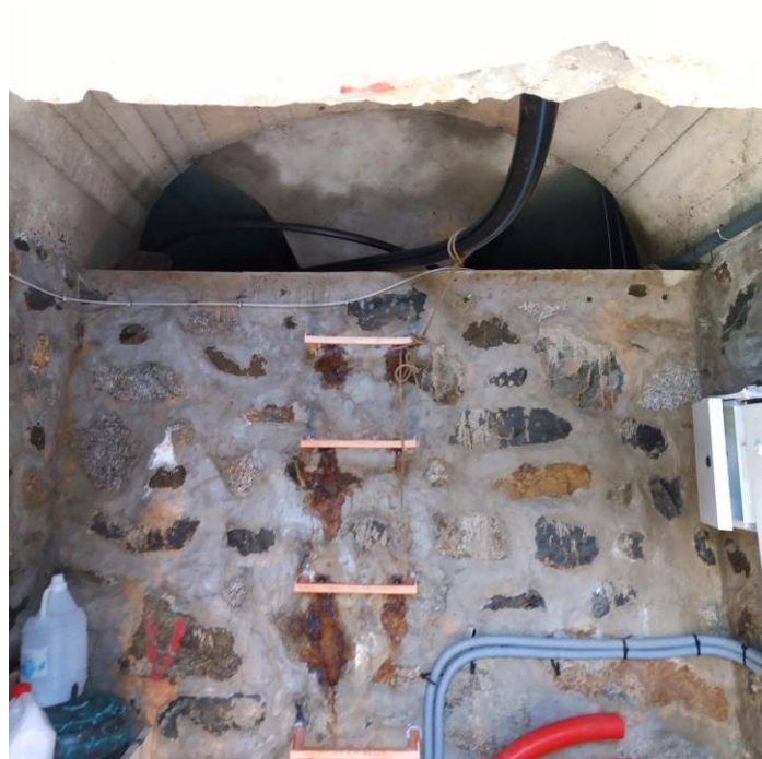
Vista frontal de los dos depósitos, desde su interior.
