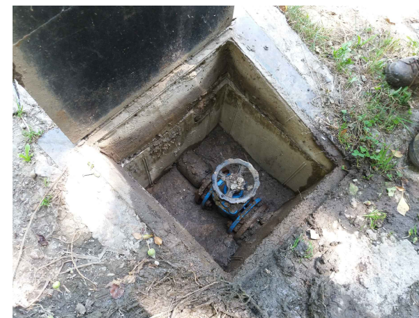
ARQUETA 3 : VALVULA DE SECCIONAMIENTO EN DISTRIBUCIÓN
