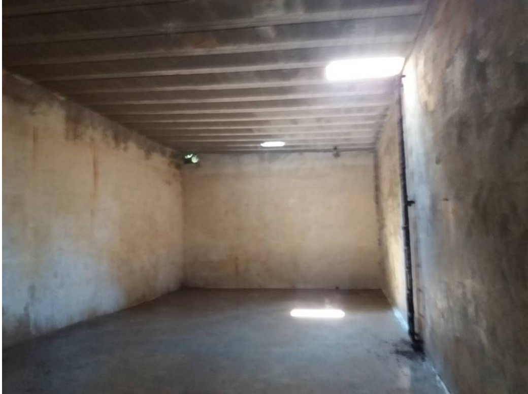
Vista interior de depósito existente
