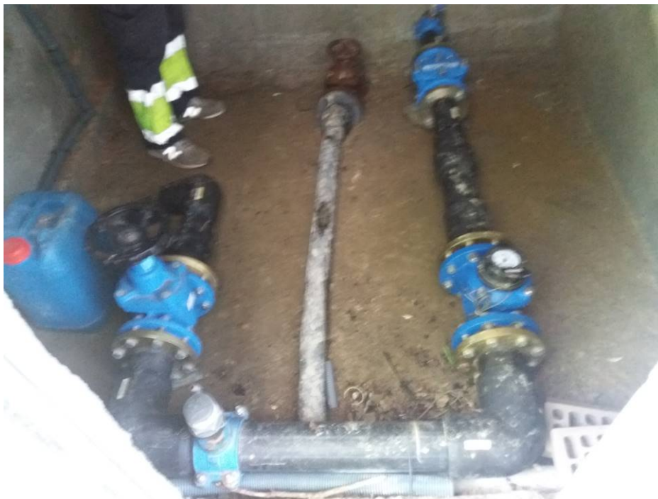
Vista de valvulería existente en interior de caseta de salida.
