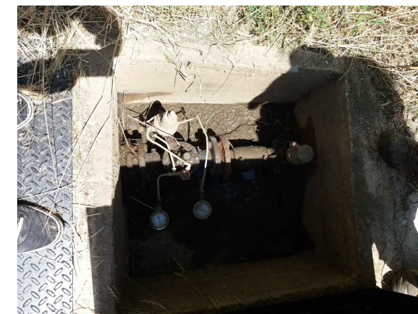
ARQUETA 4 : VÁLVULA REDUCTORA, VENTOSA Y CONTADOR EN CONDUCCIÓN DE INICIO DE RED DE DISTRIBUCIÓN
