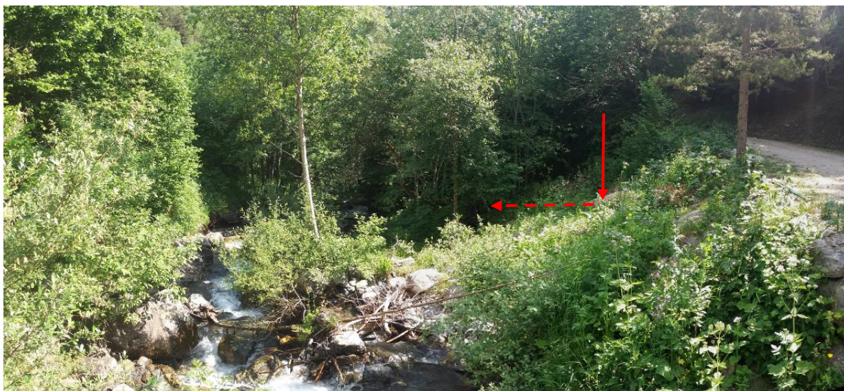
Vista de zona de ubicación de punto final de tubería de PEAD DN 75 mm, en margen derecho del barranco de Casau, pasado el puente de Badiero.
