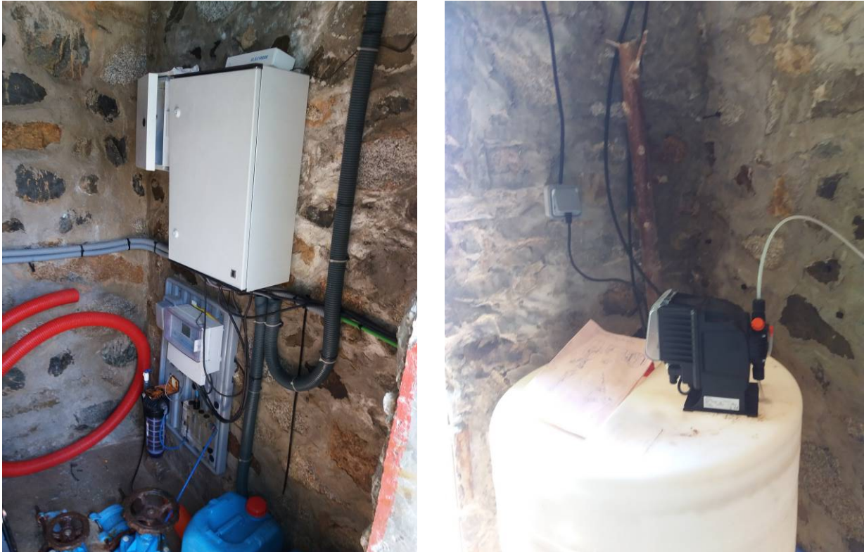
Vista de cuadro de control, sistema analizador de cloración, bomba dosificadora y depósito de hipoclorito
