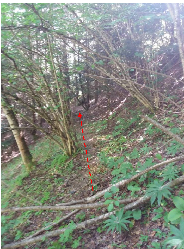
Vista de zona de paso de tubería de PEAD DN 75 mm, en margen derecho del barranco de Casau, antes de la llegada al depósito existente.
