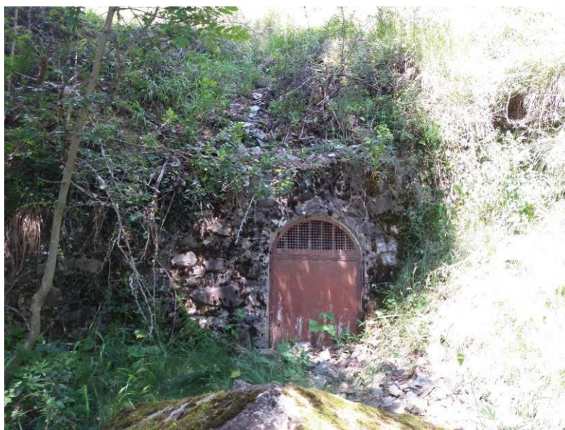
Vista de arqueta instalada en punto de surgencia natural.
