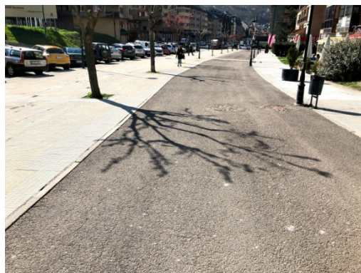
Imatge 24. Estat actual de l'Avenida deth Pas d'Arró.
