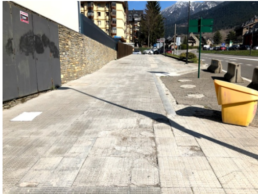
Imatge 13. Estat actual de l'Avenida deth Pas d'Arró.
