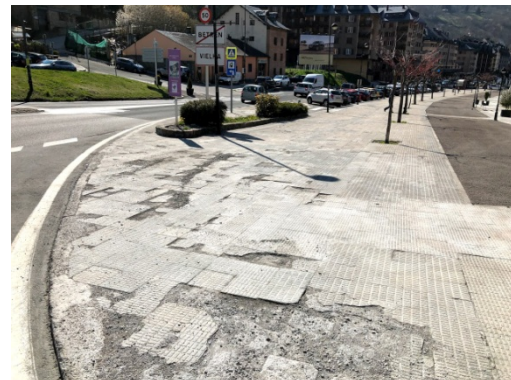
Imatge 16. Estat actual de l'Avenida deth Pas d'Arró.
