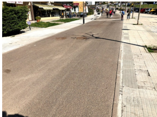
Imatge 22. Estat actual de l'Avenida deth Pas d'Arró.
