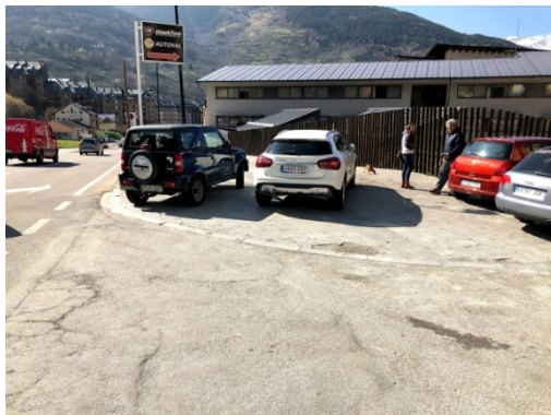
Imatge 15. Estat actual de l'Avenida deth Pas d'Arró.
