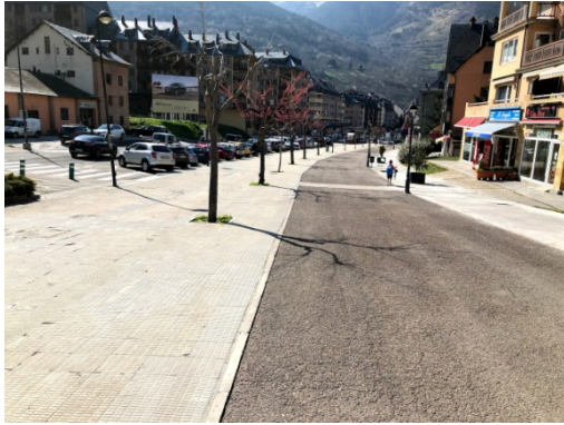
Imatge 17. Estat actual de l'Avenida deth Pas d'Arró.
