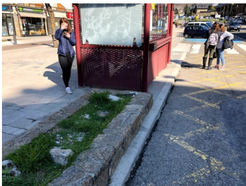
Imatge 23. Estat actual de l'Avenida deth Pas d'Arró.
