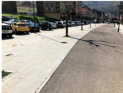
Imatge 20. Estat actual de l'Avenida deth Pas d'Arró.
