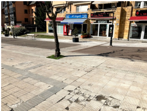
Imatge 19. Estat actual de l'Avenida deth Pas d'Arró.
