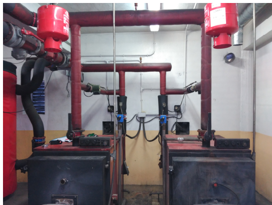
Imatge 04. Sala de calderes
