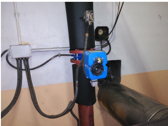
Imatge 03. Sala de calderes
